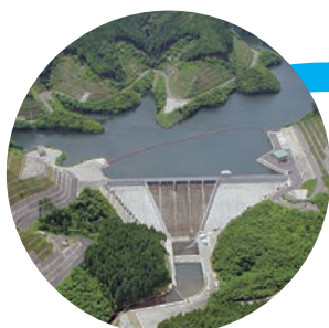
水源「谷川内ダム」
