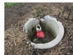
トラクター用モアによる給水栓破損
