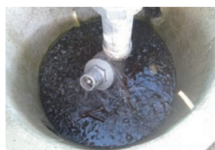
給水栓の破損による漏水
