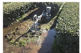
給水栓の破損による漏水
