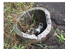
トラクター用モアによる給水栓破損
