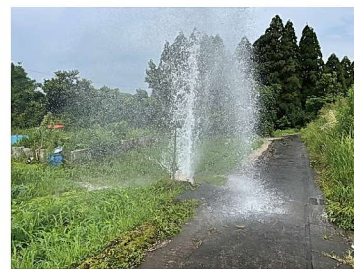
車両が給水栓に接触し漏水
