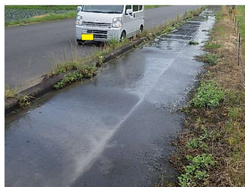
道路下に埋設したパイプラインより漏水
