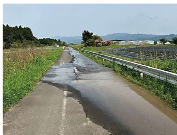
道路下に埋設したパイプラインより漏水
