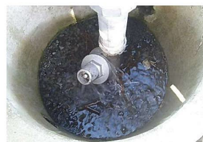
給水栓の破損による漏水
