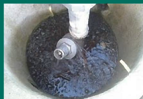
給水栓の破損による漏水
