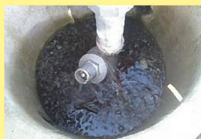
給水栓の破損による漏水
