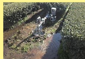
給水栓の破損による漏水
