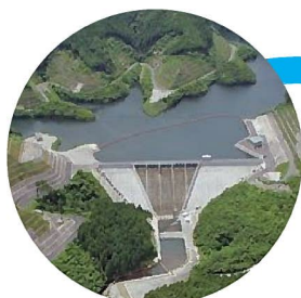
水源「谷川内ダム」
