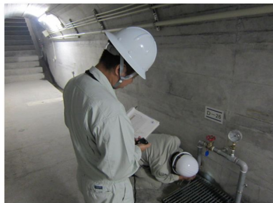
ダム監査廊浸透量計測
