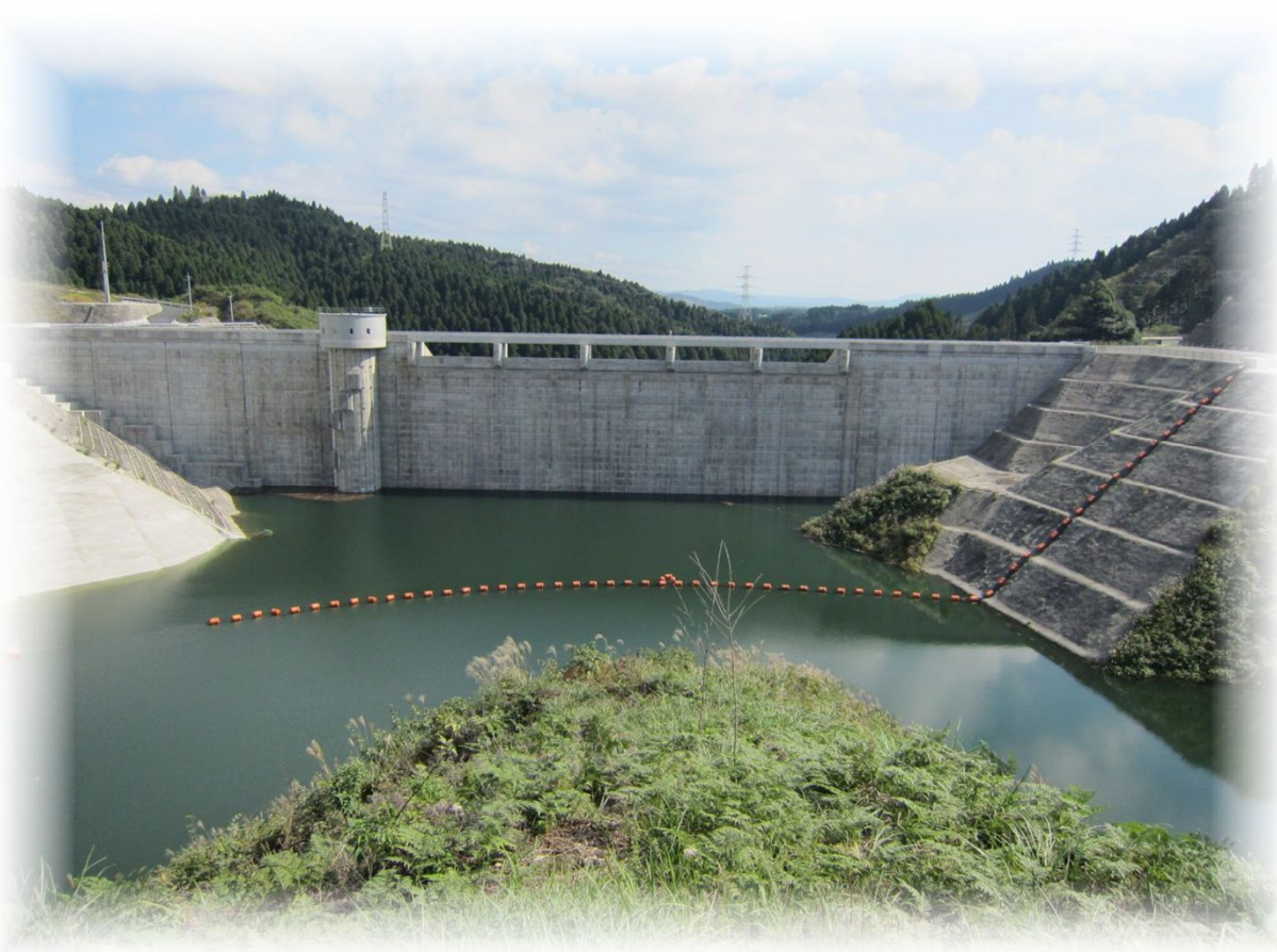
平成23年10月27日現在の谷川内ダムの貯水状況(貯水率12.8%)
